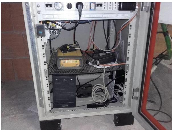
Armadio contenente il ricevitore ed il gruppo UPS
